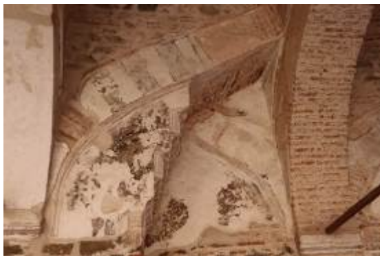
Σωζόμενα τμήματα πλαστικού και ζωγραφικού διακόσμου στον βόρειο τοίχο του αιθρίου
